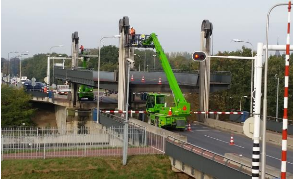
Onderhoud bij geheven brug over de nieuwe sluis
