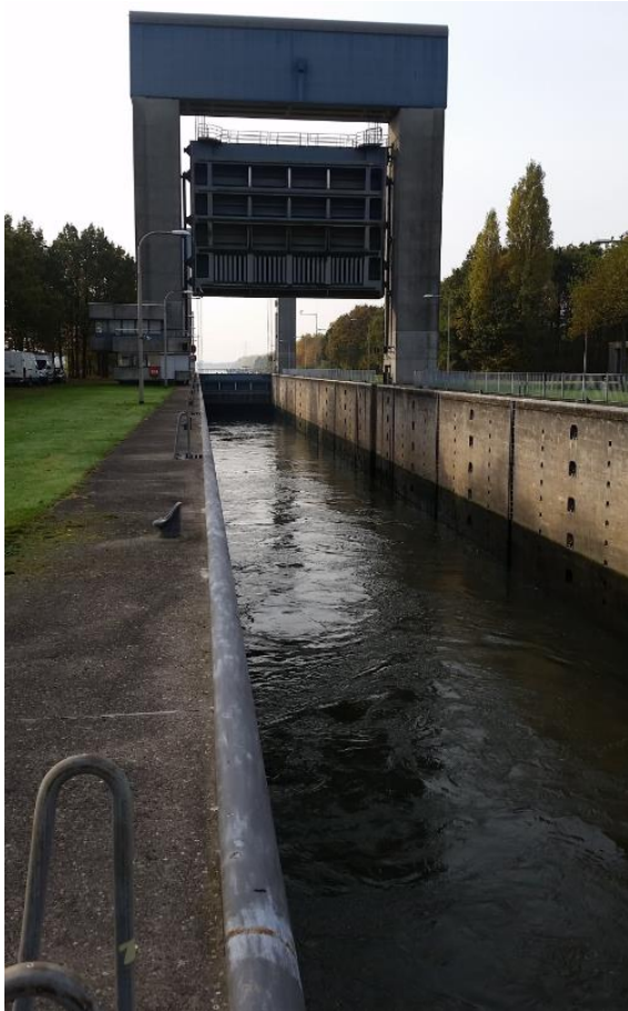
De nieuwe sluis (kijkend richting Maas-Waalkanaal)
