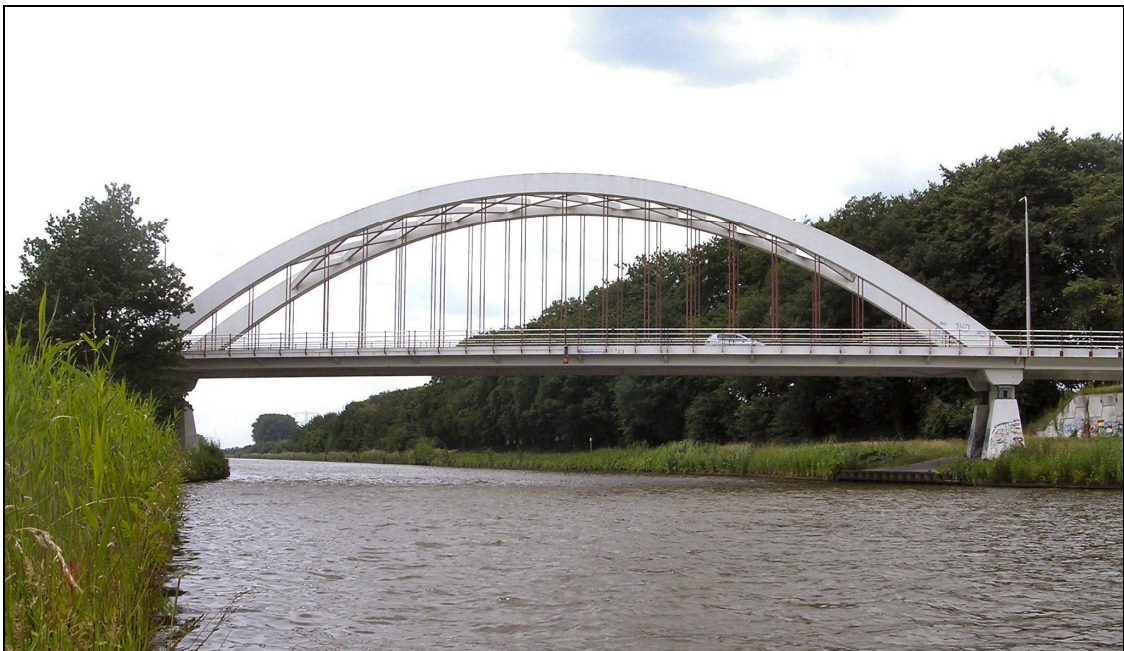
Eén van de voor het Twentekanaal kenmerkende betonnen boogbruggen met doorvaarthoogte ca. 6,50 m
