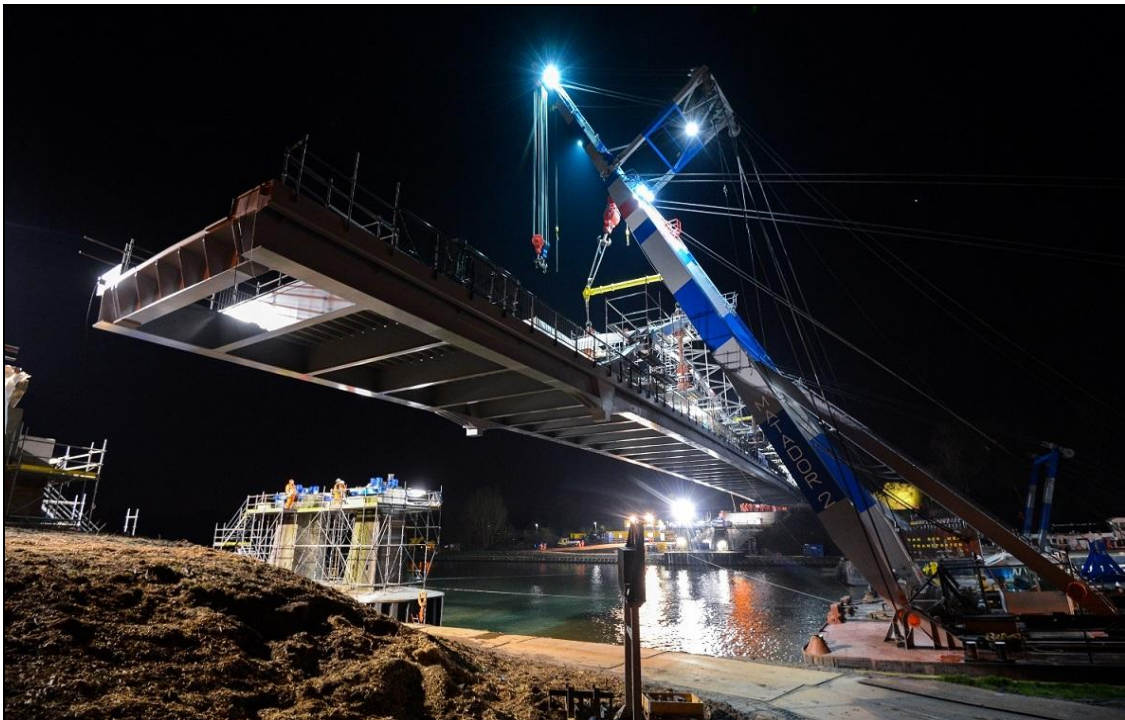
Plaatsing van de nieuwe Overeindsebrug, Amsterdam-Rijnkanaal, april 2015 (De Scheepvaartkrant)
