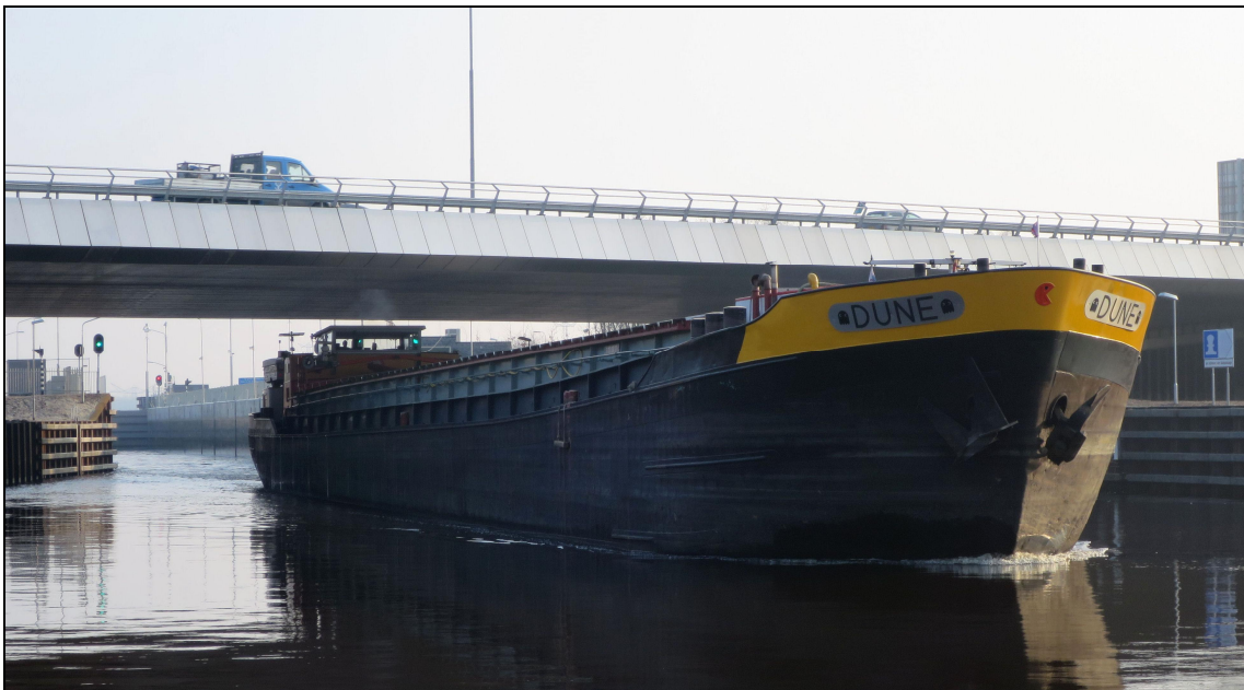
De bruggen over het Máximakanaal, zoals deze brug in de A59, zijn berekend op een \Delta h = 25 cm
