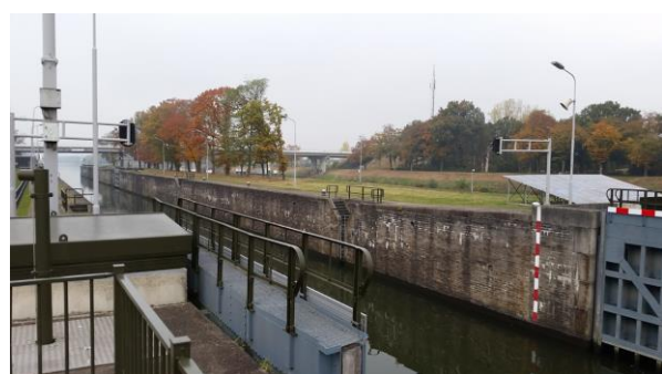
Rechts de zonnepanelen op het "eiland"
