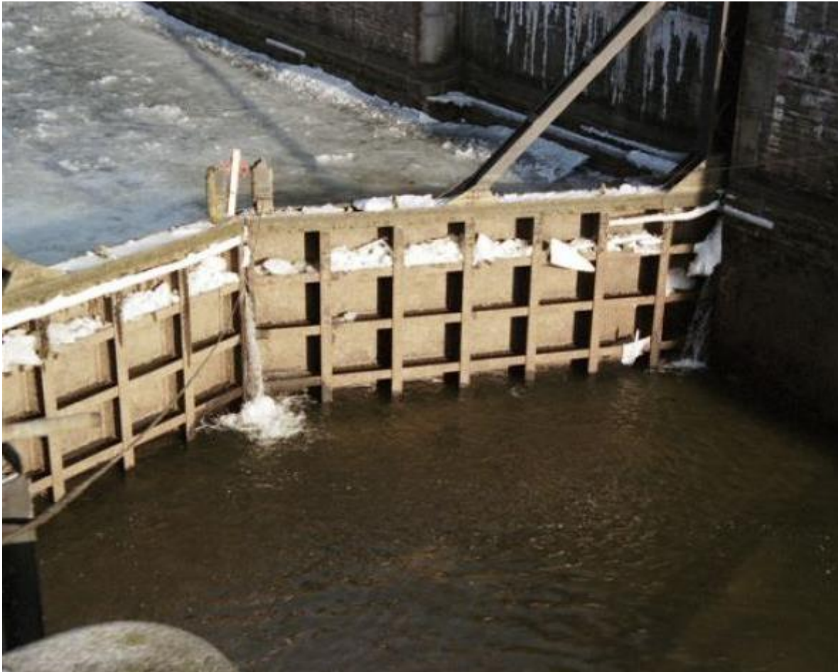
De (tijdelijke) puntdeuren die tijdens ijsgang op de Maas in sluis Heumen geplaatst worden. Rechts op de foto de lage waterstand van de Maas.
