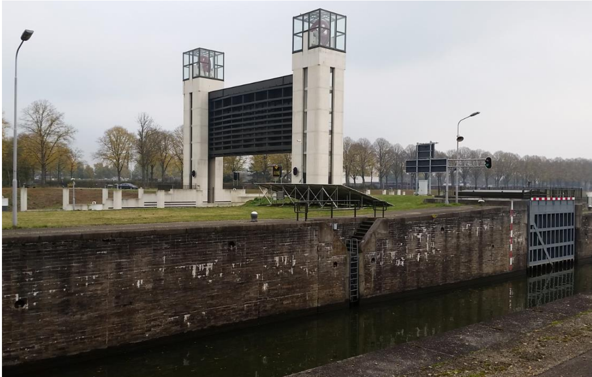
De sinds 2013 passeerbare oostelijke doorgang (keersluis) met openstaande hefdeur
