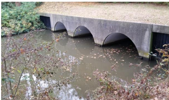
De 3 buizen in het toeleidingskanaal
