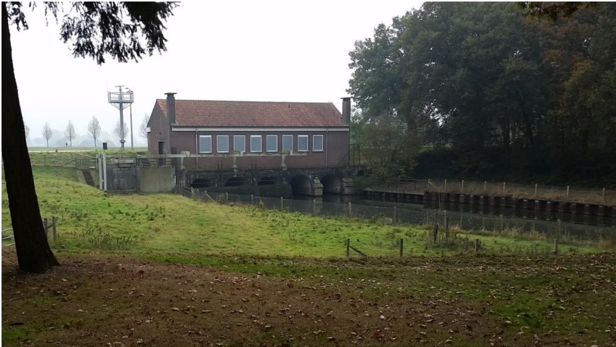
Het gebouw waarbinnen zich het gemaal van Heumen bevindt
